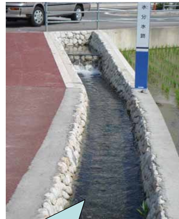
下水処理水をため池に 送水する水路
