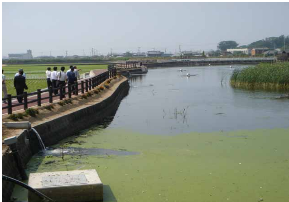
農業用のため池に下水処理水が放流される様子
